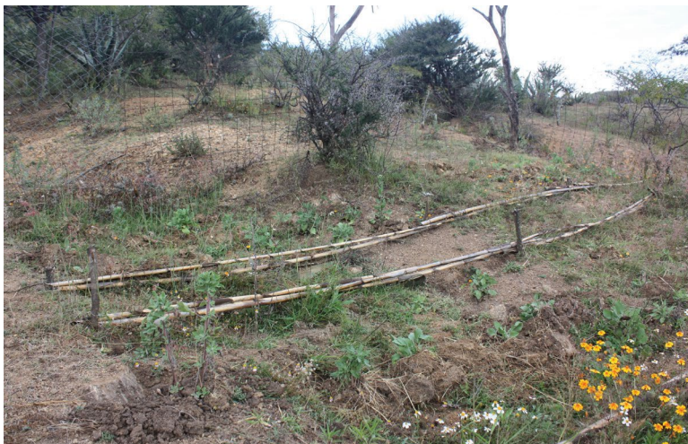
Figura 3. Obra construida en un patio con pendiente para evitar la erosión
